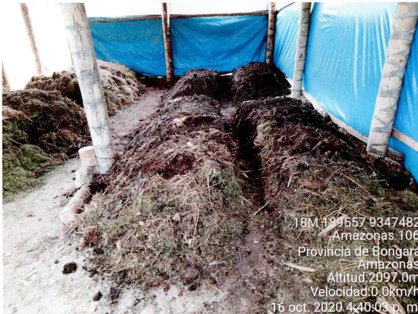
Imagen 1: Totalidad (07) de las Pilas en la Planta de Valorización de Residuos Sólidos Orgánicos
