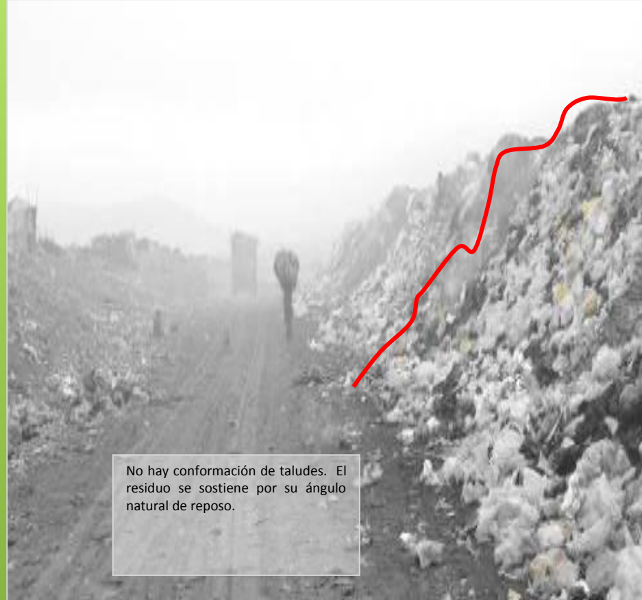
Talud de Plataformas en el Botadero Controlado El Milagro. Junio 2009
