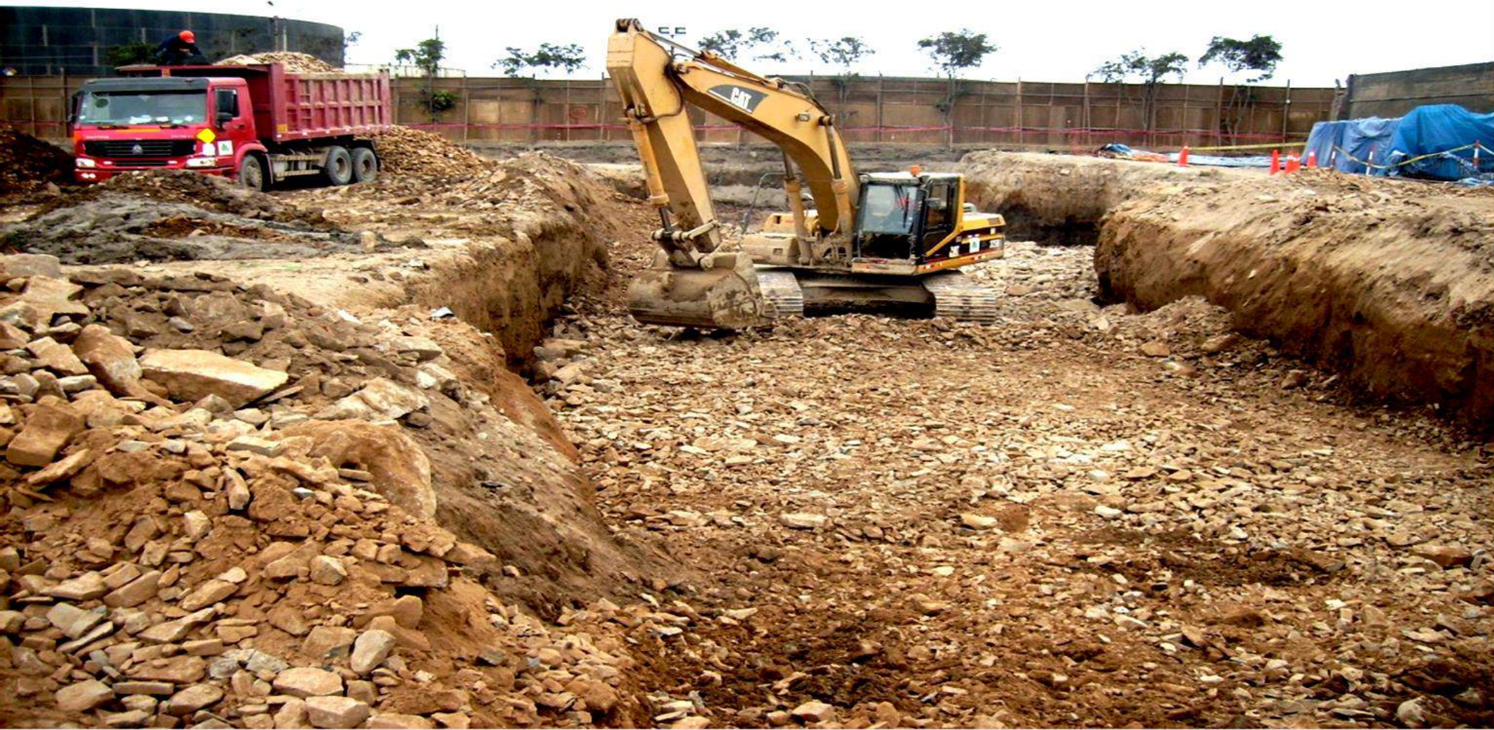
Trabajo en el Subdren
