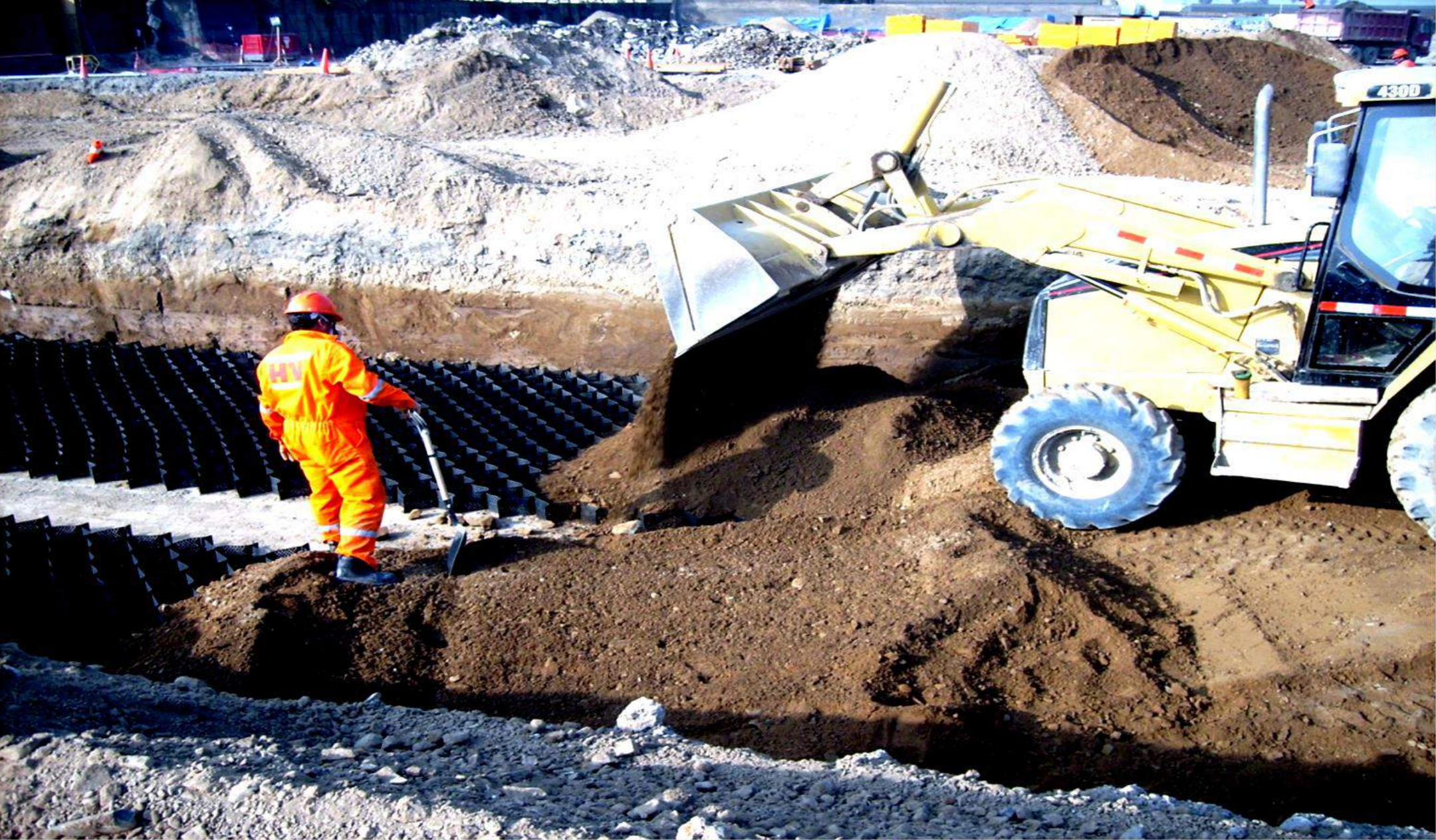
Colocación de las Geoceldas
