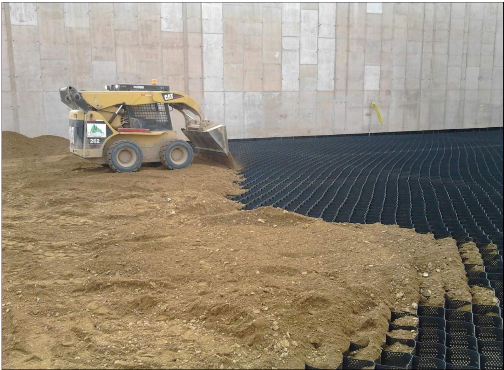
Colocación de las Geoceldas
