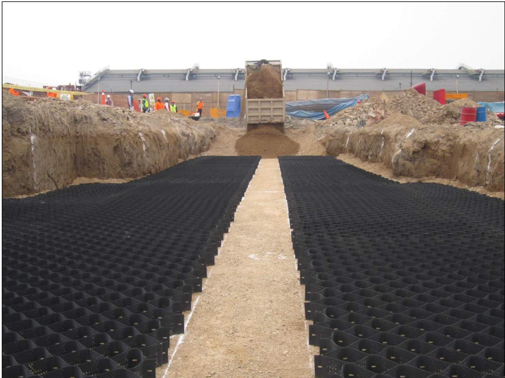
Colocación de las Geoceldas
