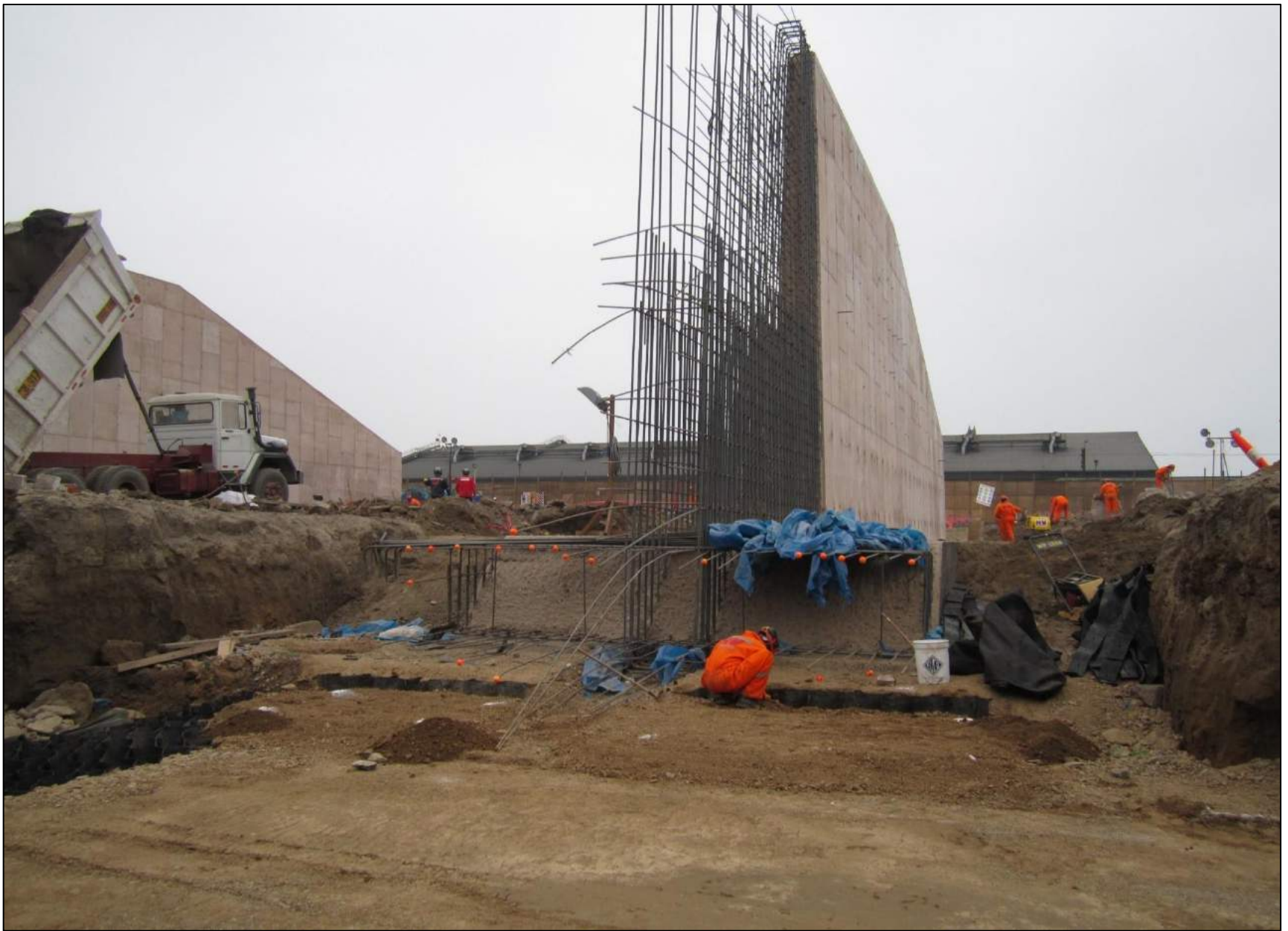
Cimentación para las Paredes de los Almacenes
