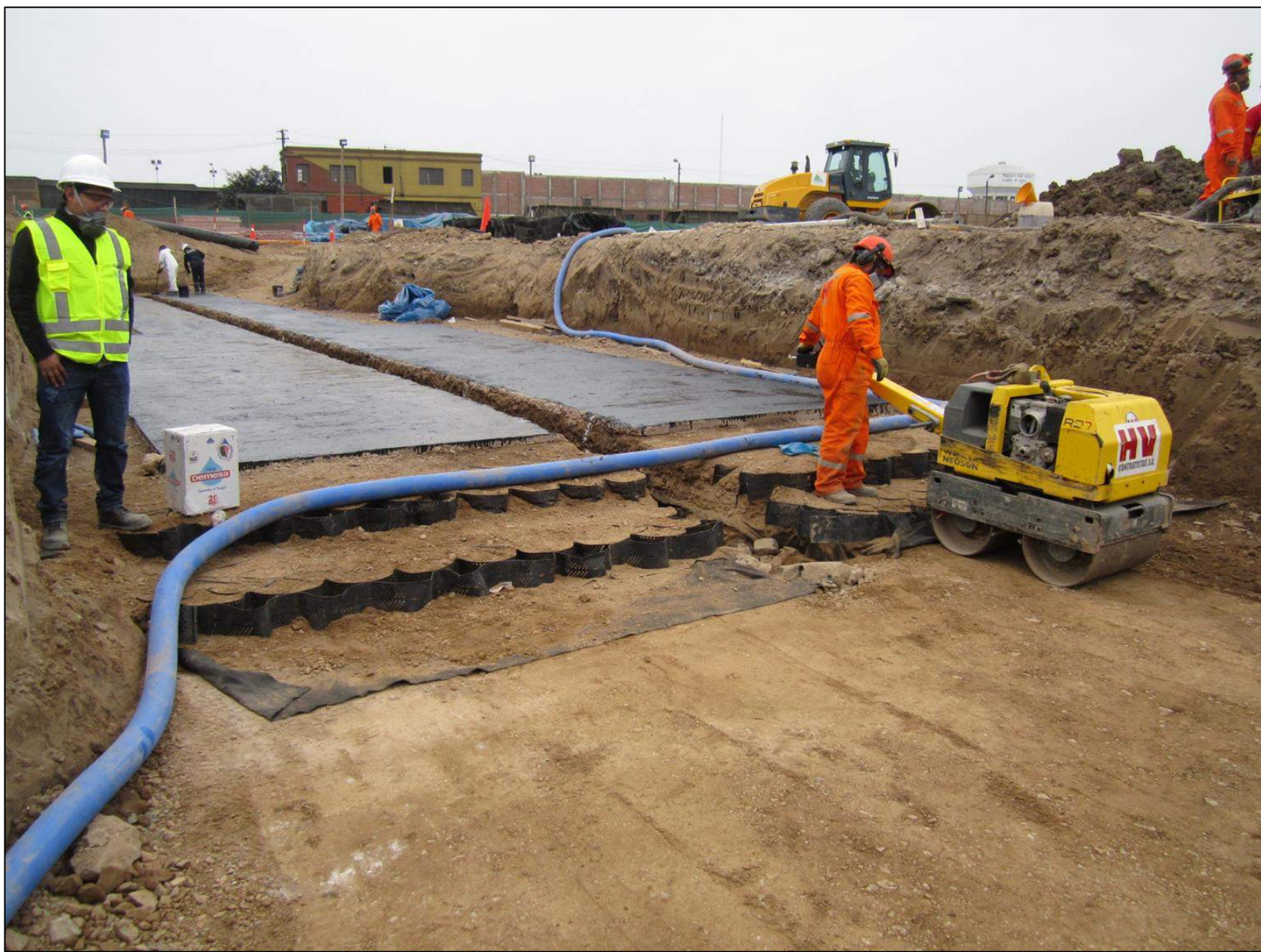
Colocación de las Geoceldas
