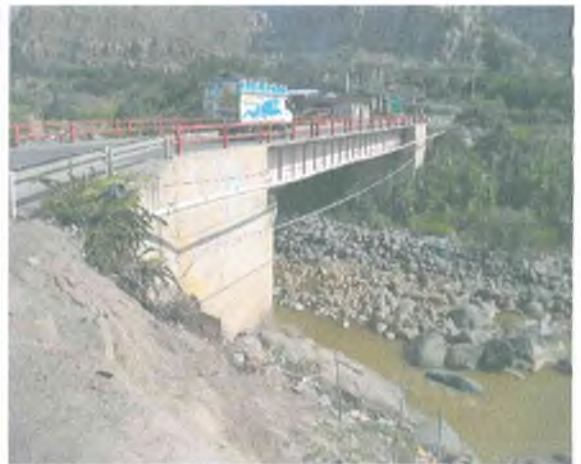
Fotografía N° 52. Punto RMoch6. Puente Concón.
