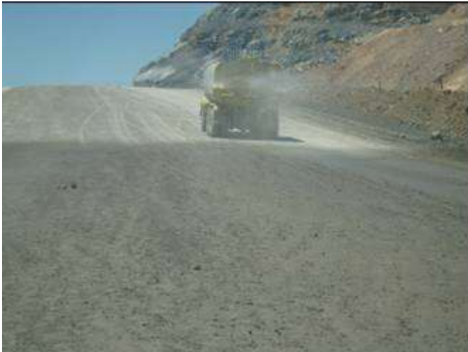
Riego de vías
