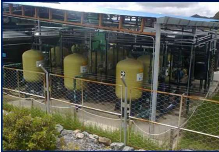
Planta de Tratamiento de Agua por Osmosis Inversa
