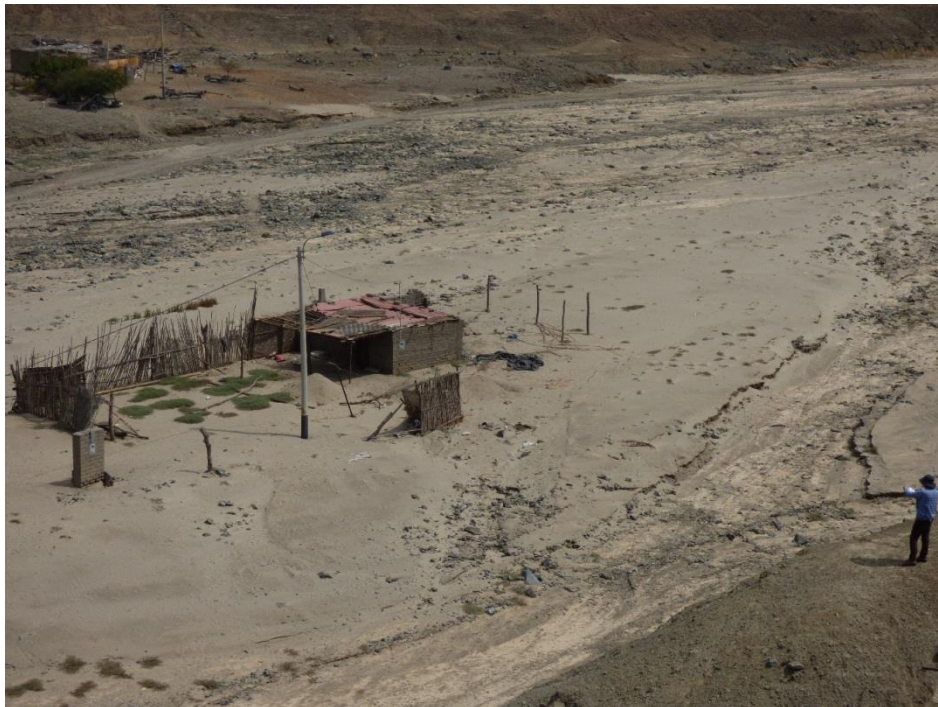
Foto 4. Vivienda e instalación de energía eléctrica ubicadas en el cauce de quebrada que fue afectada por flujo de detritos. CP. Huaca Corral, distrito Guadalupito, provincia Virú, La Libertad.
