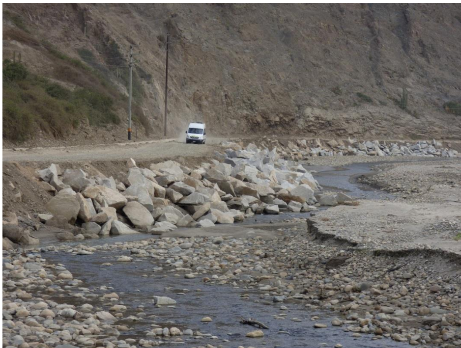
Foto 19. Rehabilitación parcial de la carretera Chicama-Cascas después de la erosión fluvial en la margen izquierda del río Chicama. Distrito Chicama, provincia Ascope, departamento La Libertad.
