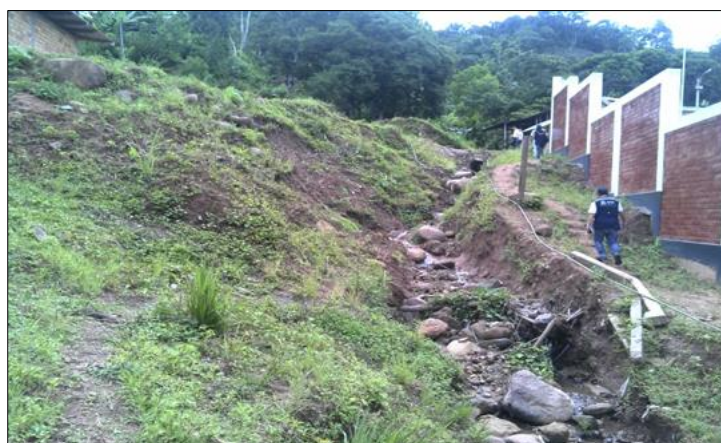
Figura 12. Localidad Alto Perú, asentado en la quebrada Torrenteras Alto Perú
