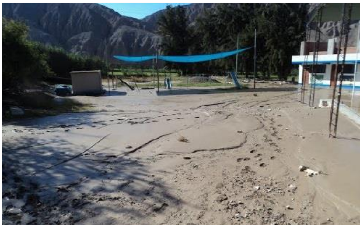
Figura 27. Centro Poblado Mirave, a orillas de la quebrada Mirave
