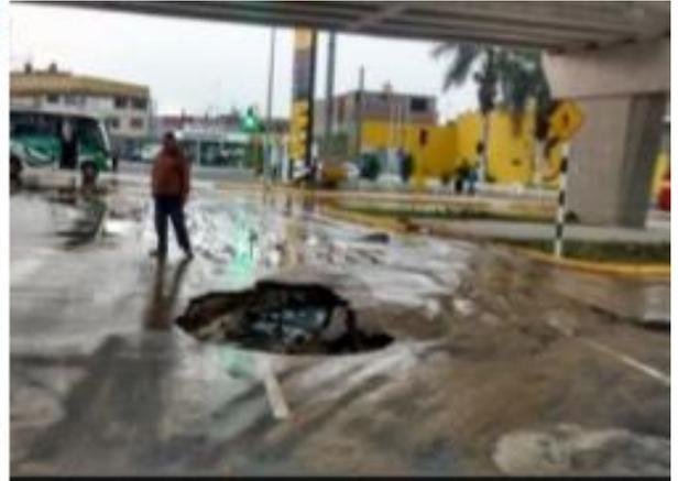
**HUNDIMIENTO DE PAVIMENTO POR COLAPSO DE TUBERIA DE ALCANTARILLADO DEBIDO A SU ANTIGUEDAD**
