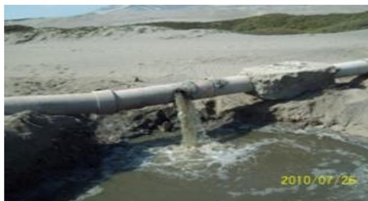
ROTURA DE TUBERIAS OCASIONADOS POR AGRICULTORES PARA RIEGO
