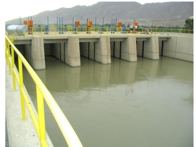
Bocatoma Talambo Zaña
