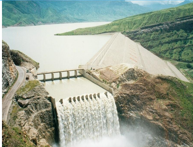
Presa Gallito Ciego
