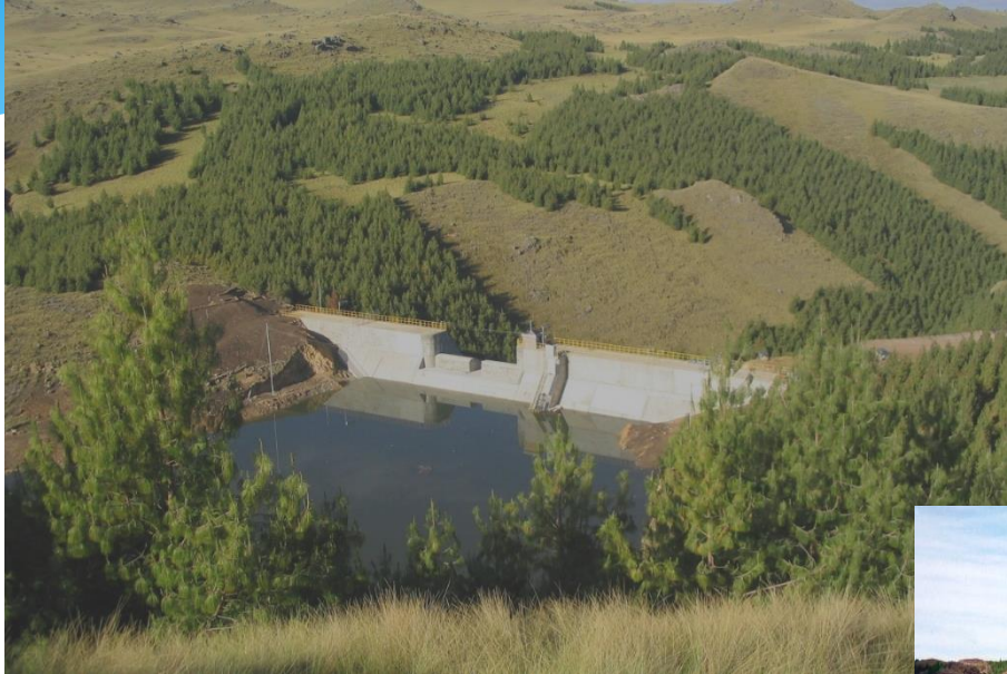
Dique sedimentador El Rejo
