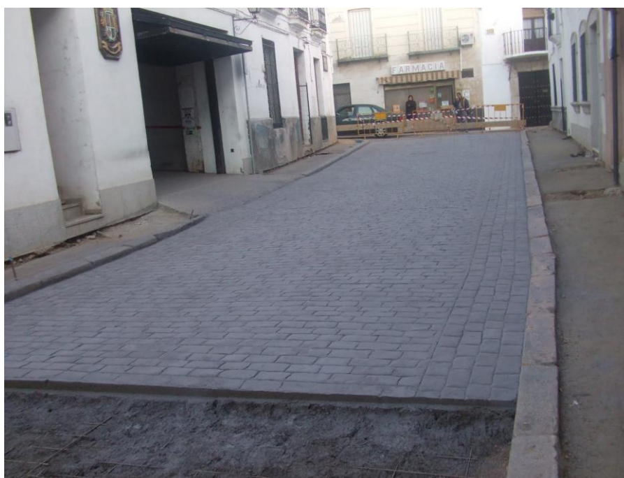
Fig. 58 Ejemplo coexistencia vías pavimentadas y concreto impreso
