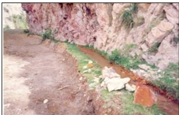
Agua de color rojizo por la presencia de hierro
