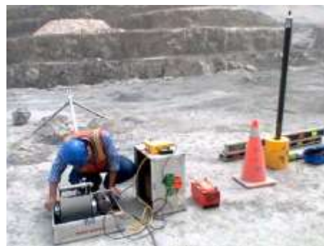
Figura 2: Instalación de sistema SIROLOG en una perforación de voladura en la cantera de Atocongo.
