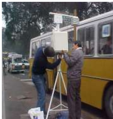
ESTACION METEOROLOGICA AUTOMATICA
