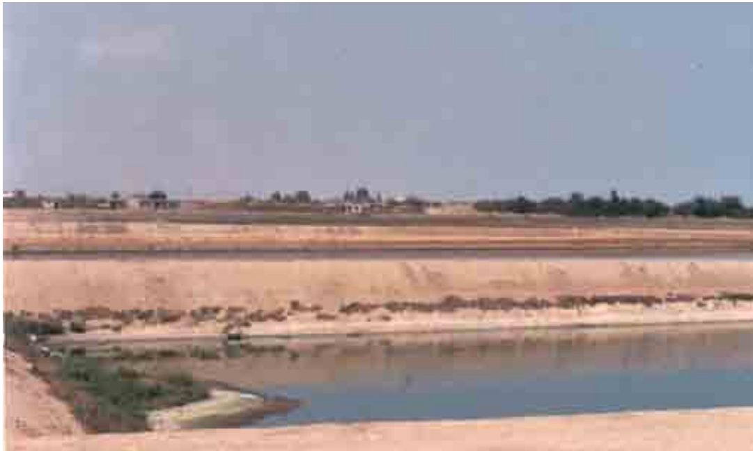
Figura 4.19. Lagunas de sedimentación del sector Valdivia Alta del distrito La Esperanza con taludes deteriorados; a escasos metros de éstas se encuentran viviendas y cultivos.
