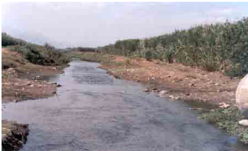
Figura 4.28. Canal de drenaje con agua estancada, ubicado en sector Santa Rosa cerca al río Moche; criadero potencial del vector de malaria.
