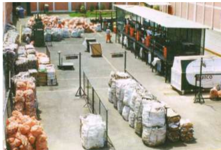
Planta de reciclaje de Santiago de Surco
