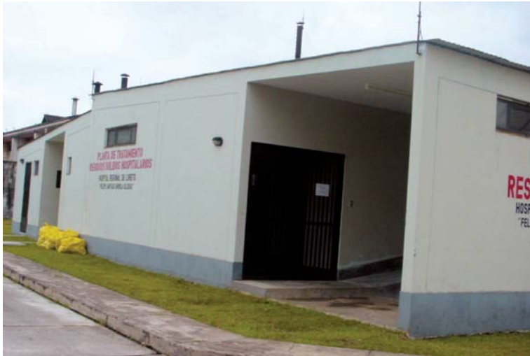
Módulo de Residuos Hospitalarios. Hospital Regional de Iquitos.
