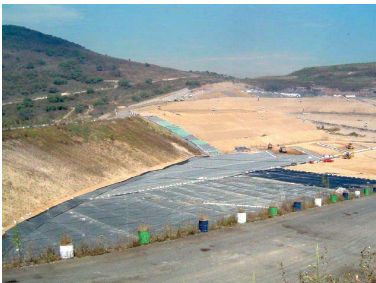
Relleno Sanitario de Tlanelpantla. Vista Horizontal.
