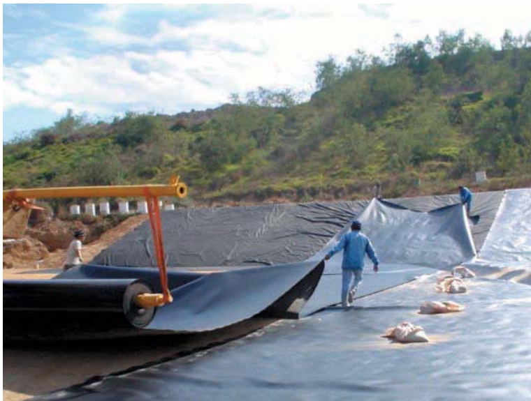
Relleno Sanitario de Tlanelpantla. Colocación de geomembrana en celda.
