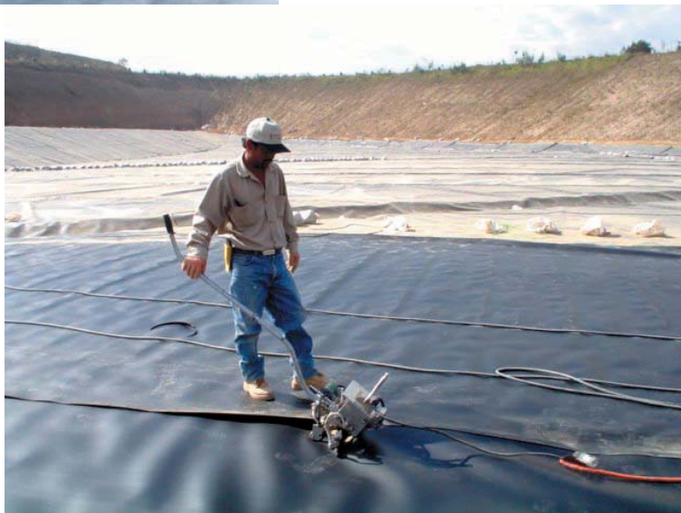
Relleno Sanitario de Tlanelpantla. Sellado térmico de la geomembrana.
