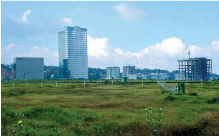
Relleno Sanitario Clausurado Prados de la Montaña. Tuberías de gas generado.
