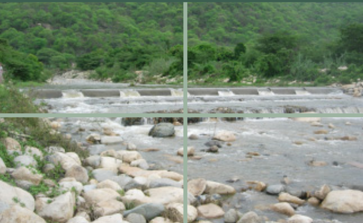
Bocatoma adecuada a crecidas del río La Gallega, Morropón - Piura
