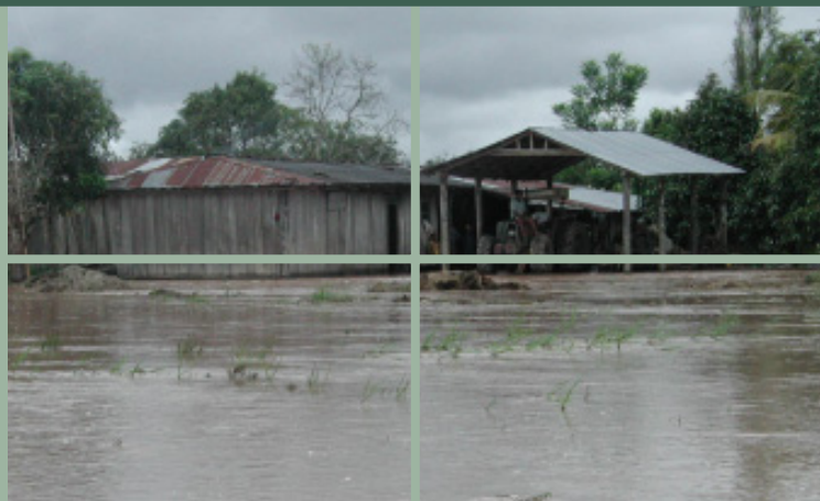
Inundación por desborde de la quebrada «El Limoncillo» - San Martín
