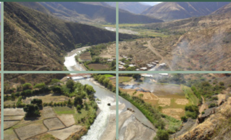
Colmatación del cauce del río Huancabamba, Pomahuaca - Cajamarca
