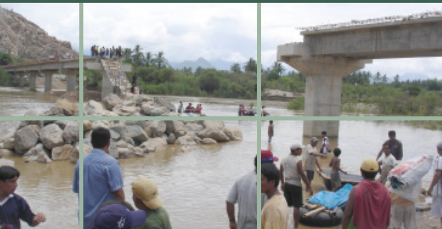
Caída del puente Carrasquillo - Piura
