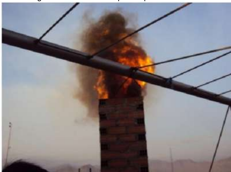
Figura 157: Se realizó la Inspección por chimeneas
