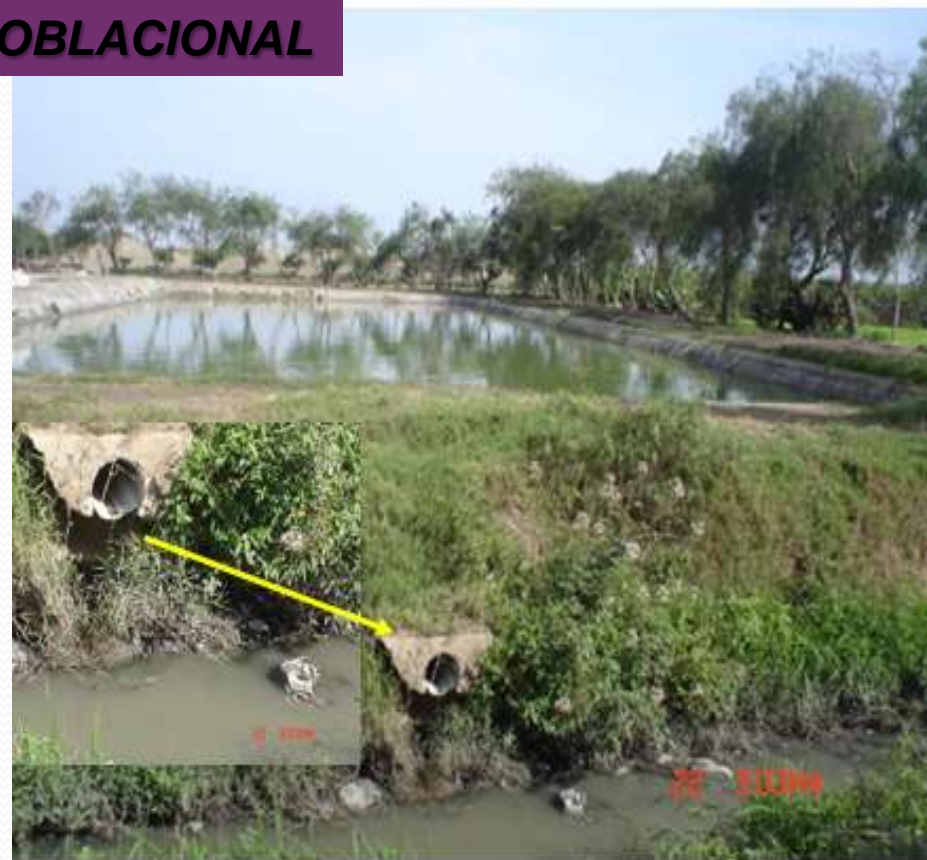
Lagunas de Oxidación del Sector Villa del Mar donde se aprecia la descarga directa al canal.
