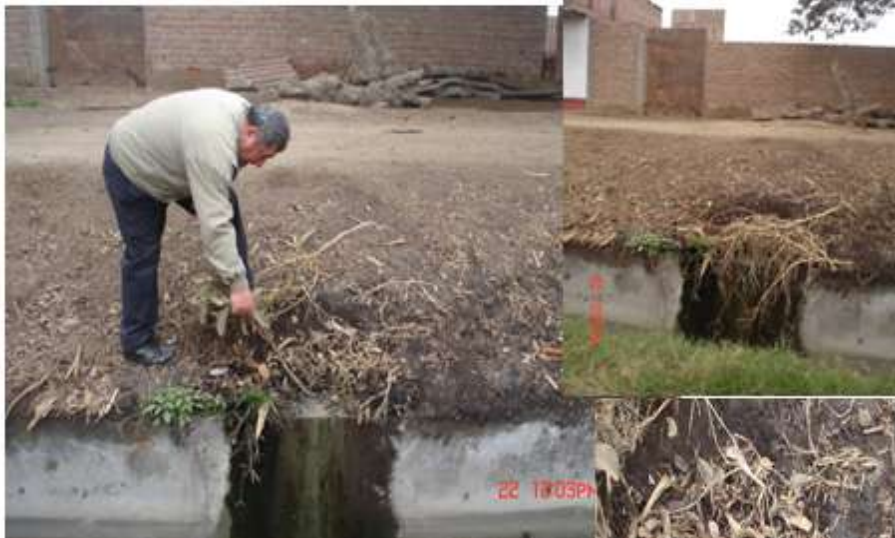
Vertimiento de Agua residual domestica directamente a canal de regadío.
