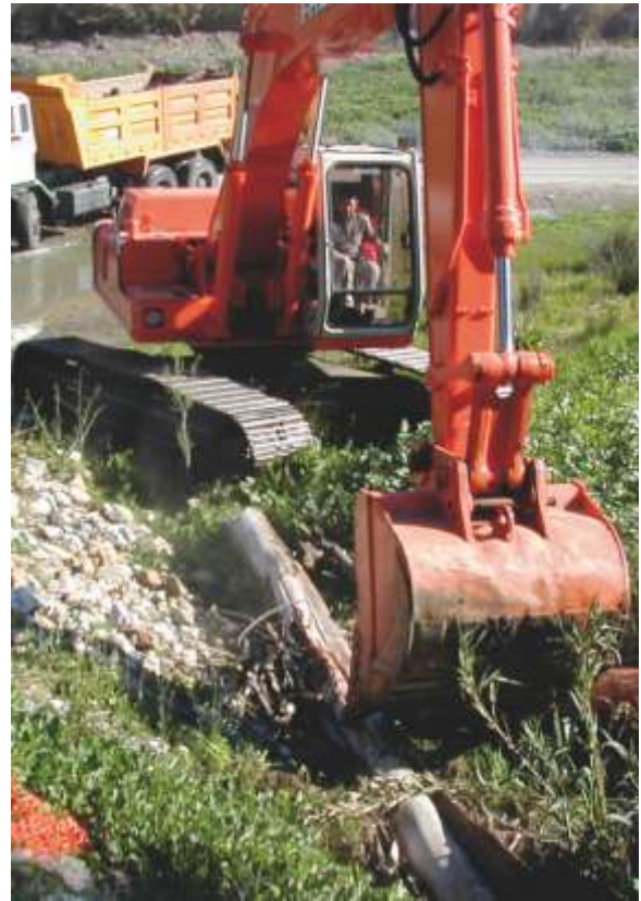
Obras de corrección hidrológica y adecuación de cauces.
