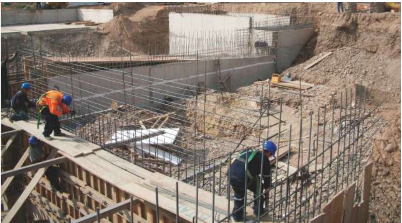
Ejecución de obra de saneamiento y depuración de aguas servidas.
