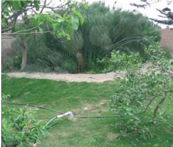
Figura N° 2.24: Humedal artificial de flujo vertical*.
