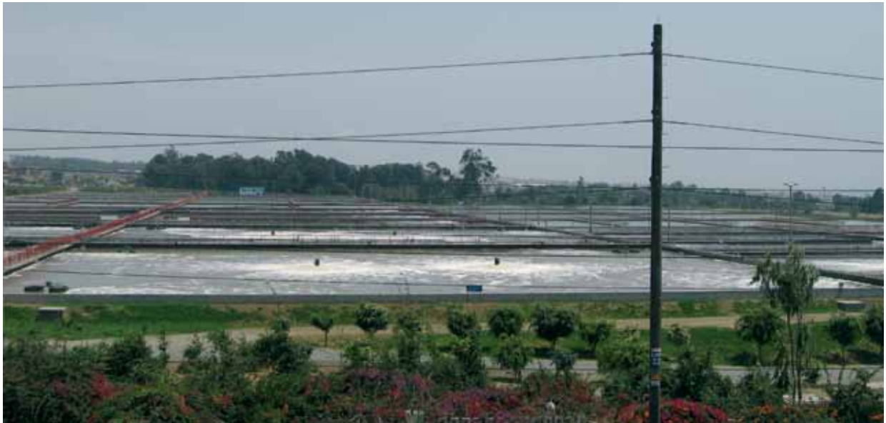
Figura N° 2.60: Planta de tratamiento de aguas servidas de San Juan de Miraflores.
