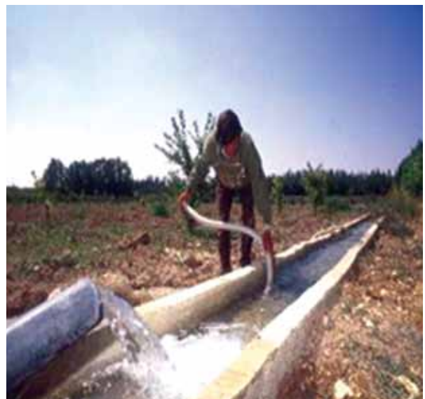
Figura N° 2.61: El uso de infraestructura complementaria para el aprovechamiento de las aguas residuales, apropiadamente tratadas en riego, representa las acciones complementarias de un proyecto integral de gestión de recursos hídricos, especialmente en zonas áridas.
