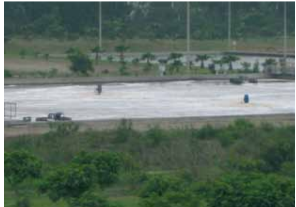
Figura N° 2.33: Sistema de lagunas aireadas que emplean aireadores mecánicos.
