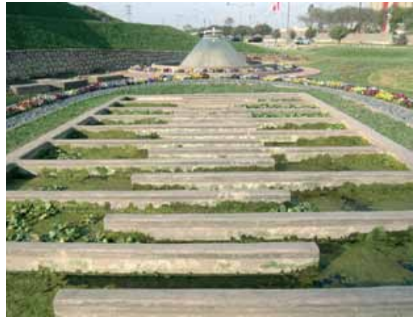
Figura N° 2.1: Vista panorámica de un Sistema de Tratamiento de Aguas Residuales domésticas, implementado en el distrito de San Borja - Lima.
