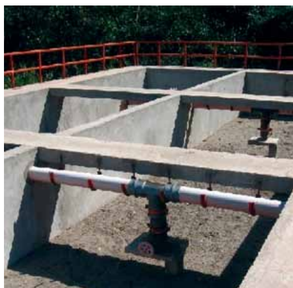
Figura N° 2.13: Lecho de secado para el tratamiento de lodos procedente de un Tanque Imhoff.
