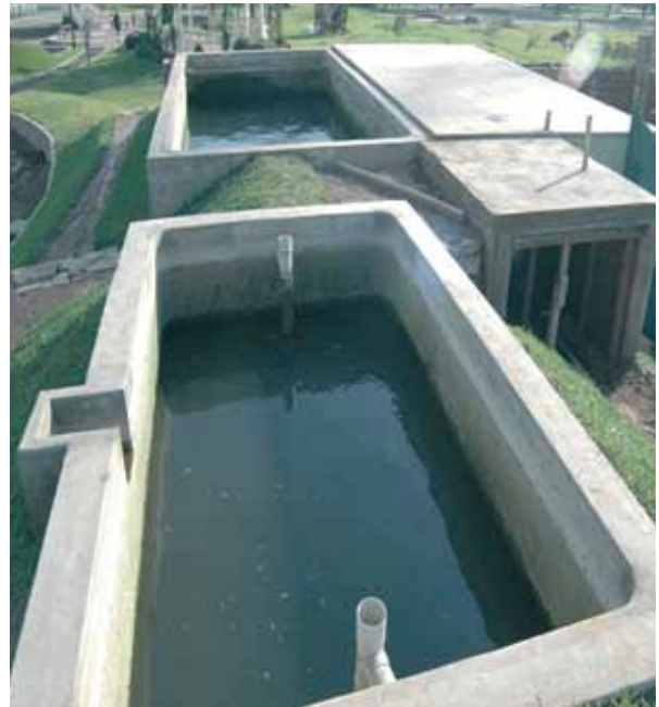
Figura N° 2.2: El tratamiento de las aguas residuales se realiza mediante un conjunto de operaciones y procesos secuenciales, que reducen progresivamente el contenido de sustancias y elementos contaminantes del agua que ingresa a la Planta de tratamiento.
