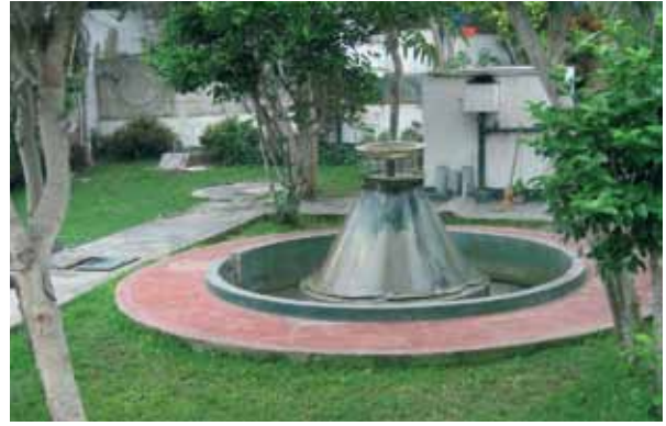
Figura N° 2.17: Filtro percolador modificado ubicado en el parque María Reiche del distrito de Miraflores, Lima.
