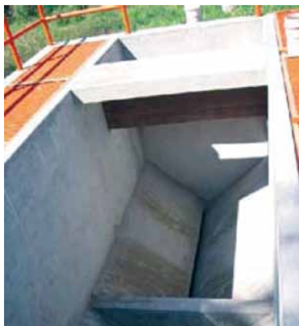
Figura N° 2.13: Lecho de secado para el tratamiento de lodos procedente de un Tanque Imhoff.
