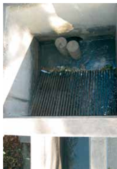
Figura N° 2.39: Detalle de la trampa de rejillas.
