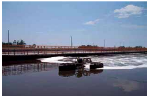
Figura N° 2.4: Vista panorámica de un sistema de tratamiento de aguas residuales por medio de lagunas aireadas.
