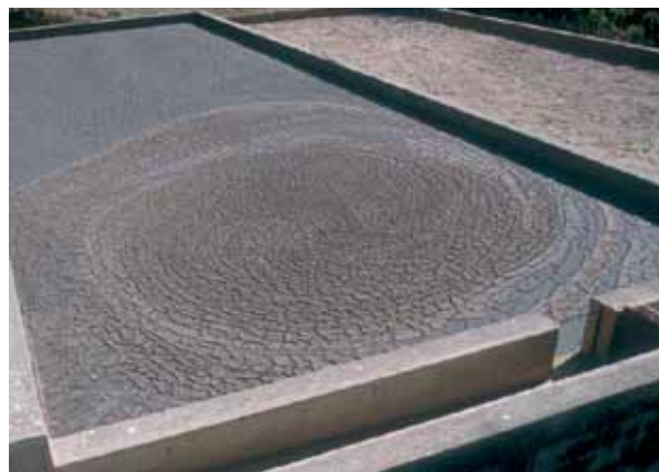
Figura N° 2.63: Vista panorámica de unidades de lecho de secado, empleado en el tratamiento de lodos procedentes de reactores y sedimentadores de una planta de tratamiento.
