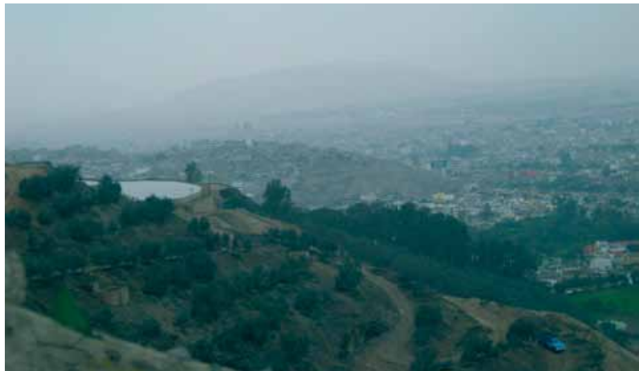
Figura N° 2.31: Las aguas residuales son bombeadas desde un ramal principal de desagüe hacia la cima del cerro donde se inicia el tratamiento. En la foto se observa la laguna primaria.
