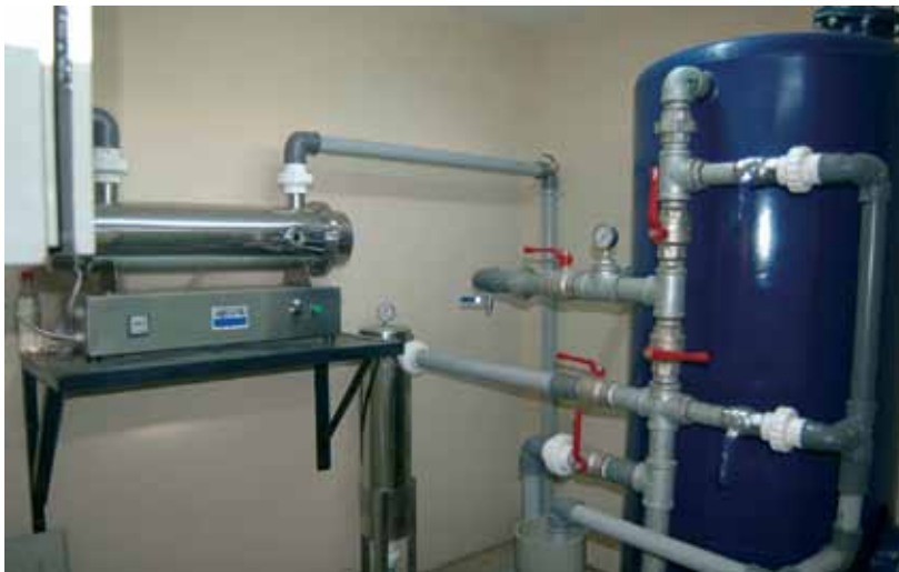
Figura N° 2.21: Filtro a presión con una capa de grava y arena para remoción de huevos de helmintos, seguido de un sistema de desinfección por radiación ultravioleta previo a su reuso en riego de áreas verdes.
