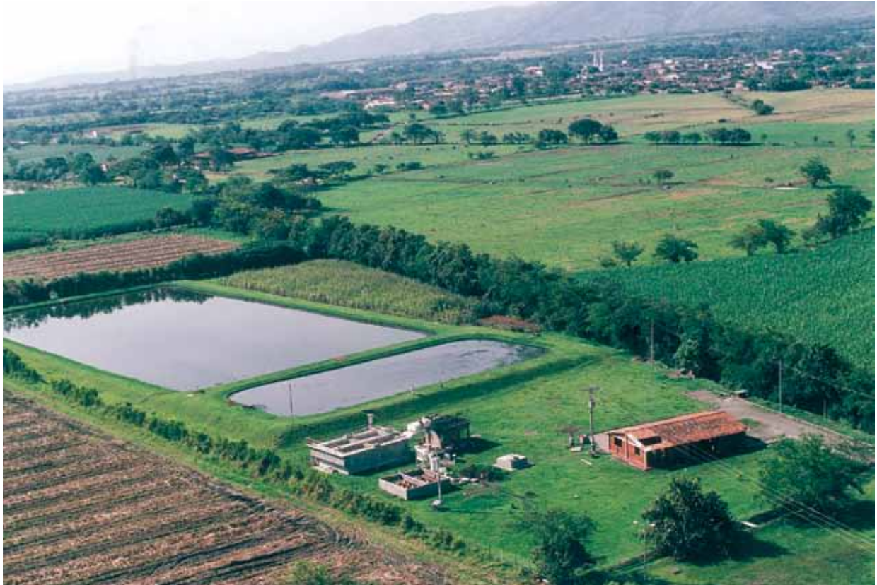
Figura N° 2.48: Uso del efluente de la planta de tratamiento de Ginebra (Colombia) en el riego de caña de azúcar.
