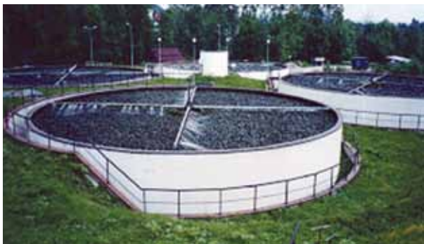
Figura N° 2.15: Vista panorámica de una batería de filtros percoladores. Estas unidades de tratamiento biológico, por bacterias adheridas al medio filtrante, permiten remover materia orgánica sin requerir energía eléctrica para su funcionamiento.
