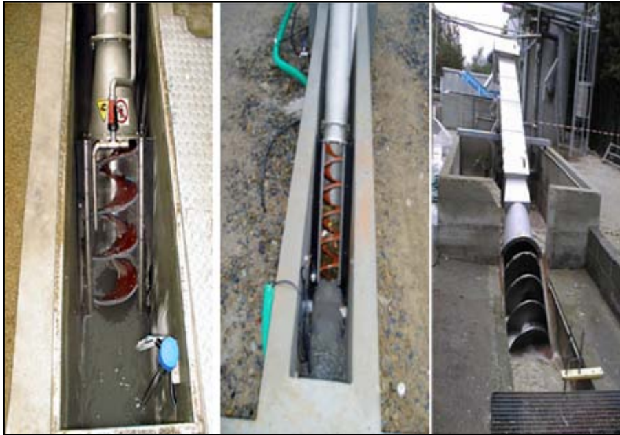
Imagen 61: Modelos de Tamiz de tornillo de la empresa WAM GmbH montados en diferentes cajas bajo distintos ángulos de inclinación.
