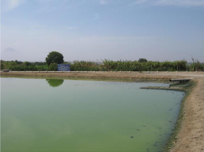
➤ **Deficiente tratamiento (pozas/lagunas de oxidación) o falta de éste en las aguas residuales (domiciliarias e industriales). Generación actual en Trujillo de aprox. 550 l/s. Sistema de alcantarillado antiguo (perdidas y fugas) o inexistente.**
