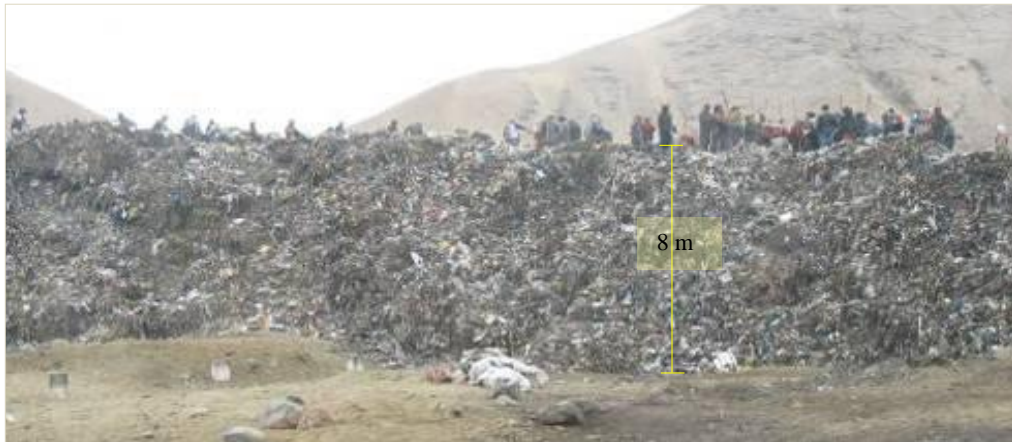
Fotografía 16. Altura de plataformas en el Botadero Controlado El Milagro. Junio 2009
