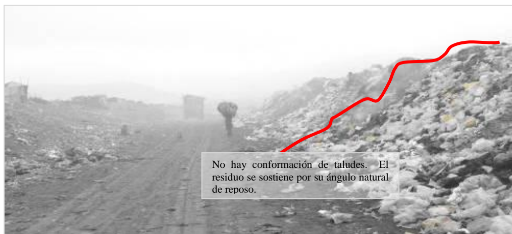
Fotografía 17. Talud de Plataformas en el Botadero Controlado El Milagro. Junio 2009
