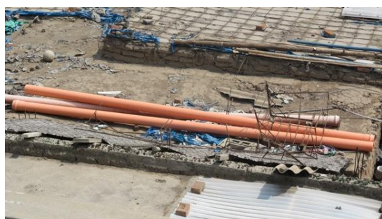
Fotografía 9. Basura en techos
