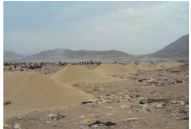
Foto 06.- Arenilla en plataforma de trabajo del Botadero El Milagro para su sellado.
