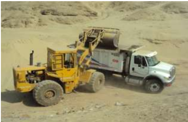
Foto 05.- Realizando trabajos de subir material inerte (arenilla) a plataforma de trabajo para su posterior sellado.
