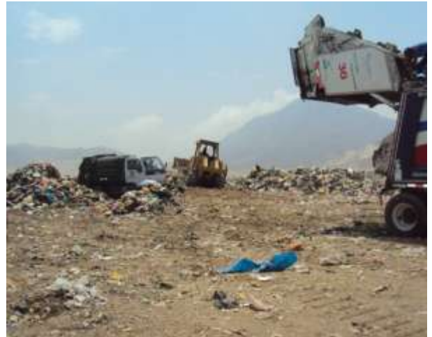
Foto 03 y 04.- Cargador frontal CAT 966 del SEGAT y tractor oruga de la Municipalidad de la Esperanza realizando trabajos de compactación en plataforma de trabajo en Botadero El Milagro.
