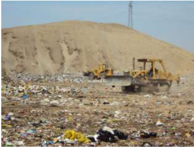
Foto 03 y 04.- Cargador frontal CAT 966 del SEGAT y tractor oruga de la Municipalidad de la Esperanza realizando trabajos de compactación en plataforma de trabajo en Botadero El Milagro.
