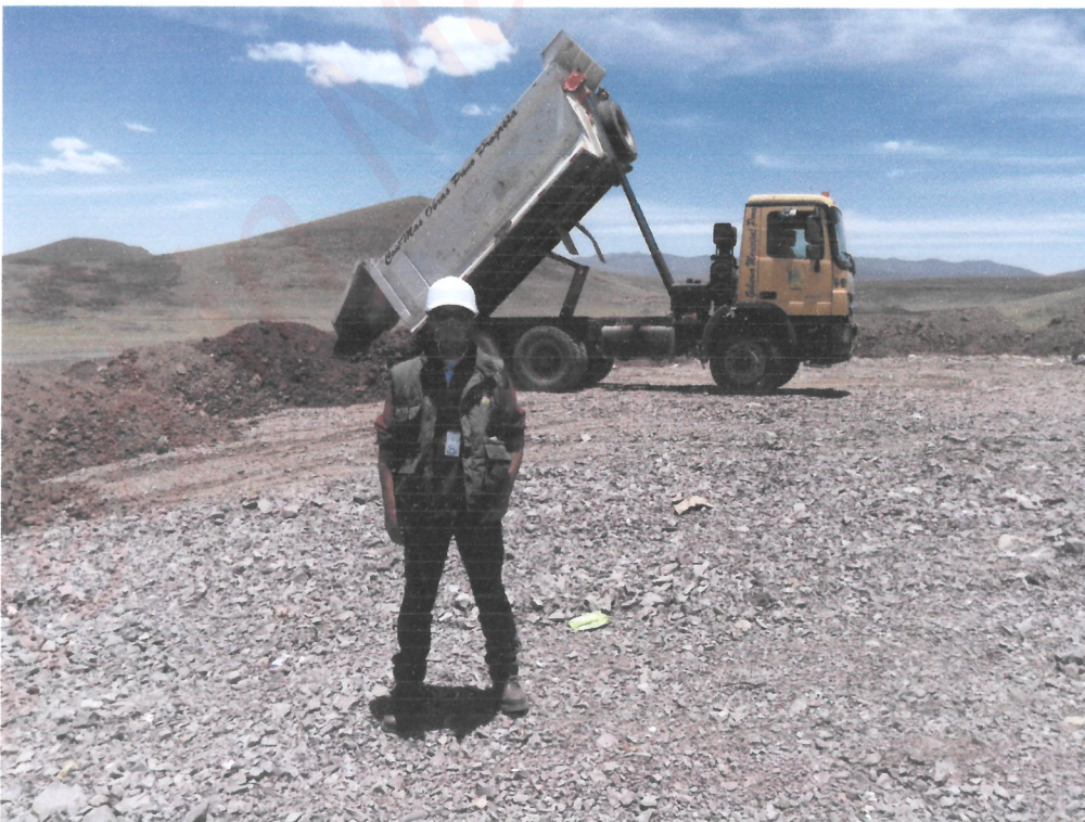
Fotografía 10.- EPP utilizados en los trabajos de recubrimiento.
