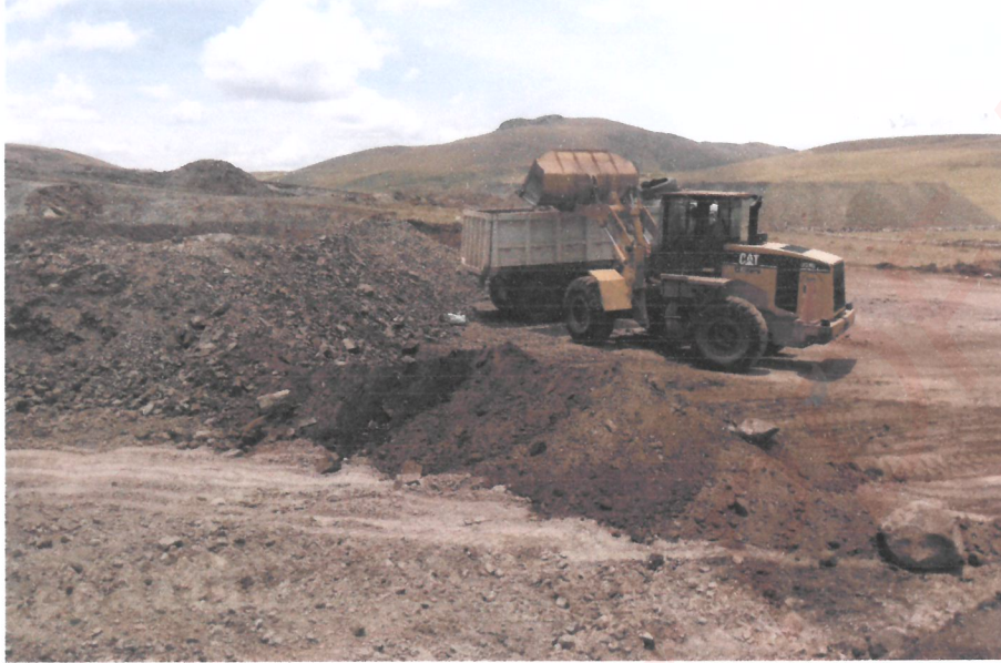
Fotografía N° 6. Carguío de material de cobertura.
