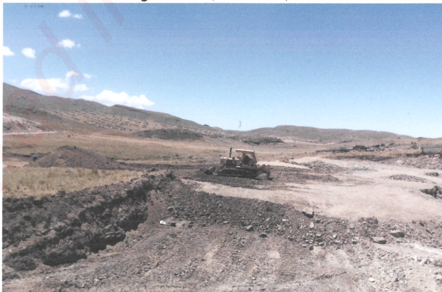
Fotografía N° 5. Tractor Oruga CAT D7, extracción, acarreo de material de cobertura.
