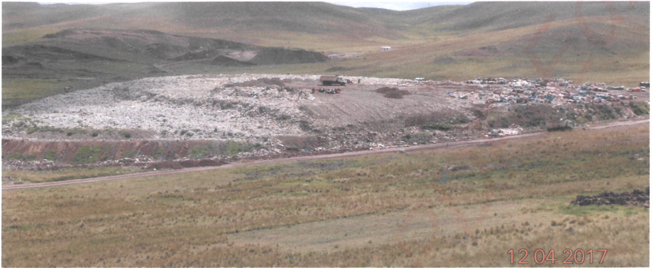
Fotografía 4.- Situación del Botadero de Cancharani 12 de Mayo – 2017.
