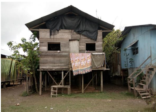
Figura 2. Vivienda preparada para tolerar las inundaciones, ventanas sin cristales y techo separado del muro para facilitar el ingreso del viento fresco.
