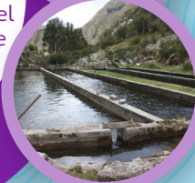
ESTANQUE DE CONCRETO DISTRITO DE PALCA, HUANCAVELICA
