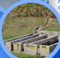
ESTANQUE DE CONCRETO, DISTRITO DE YANACANCHA, PASCO
