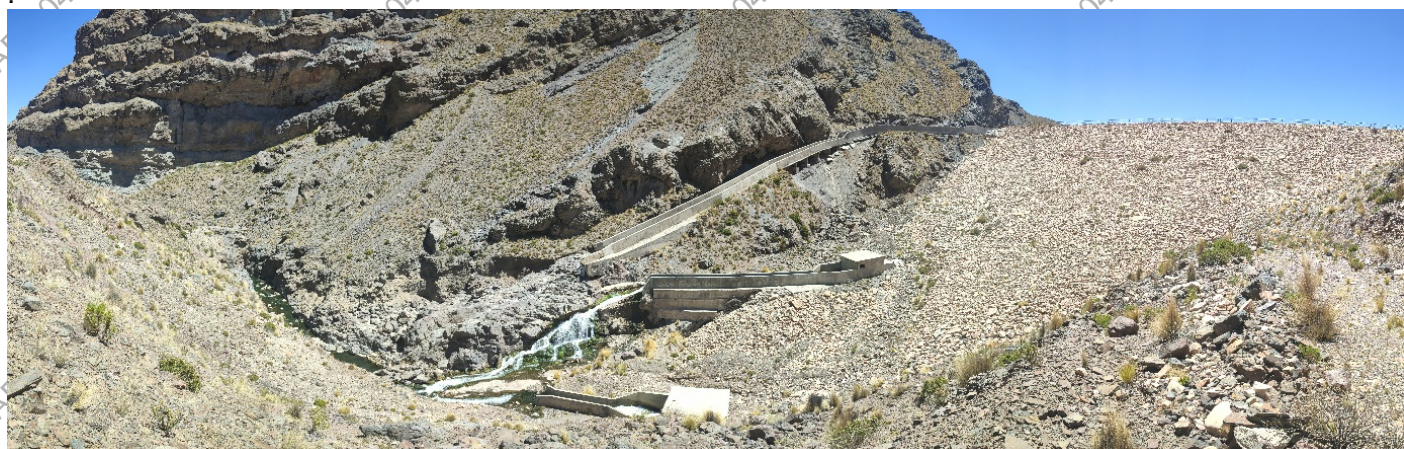
Foto N° 29: vista panorámica de la presa Chirimayuni y su descarga por medio de los canales de concreto hacia el río Umalso
