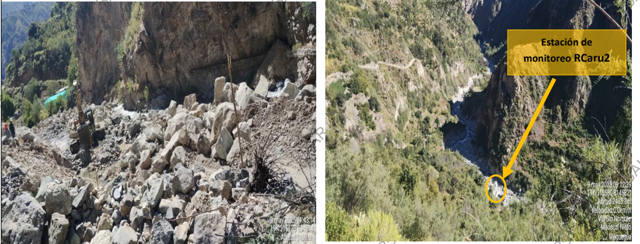
Foto N°166: Vista panorámica de la nueva ubicación de los puntos de monitoreo RCaru1 y RCaru2 por los trabajos y deslizamientos de tierra presentados.
