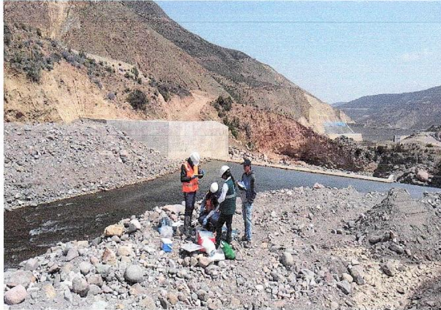
Foto N° 02: Estación 13172RAsan2. Aguas arriba del canal de desvío del Río Asana.
