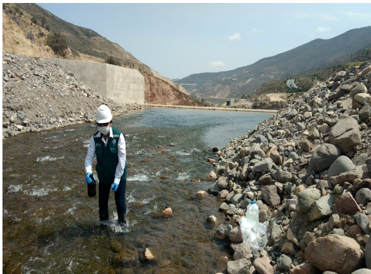
Fotografía N° 02: Estación 13172RAsan2. Bocatoma antes del desvío del Río Asana.
