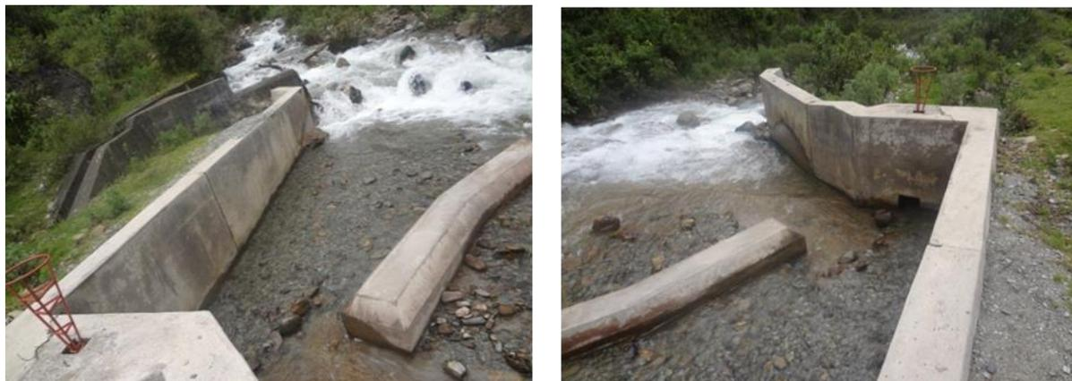
La bocatoma hacia Tomacaya capta las aguas del río Achaco y se ubica en la cota 3133.038 m.s.n.m y coordenadas UTM 773435.389E, 8511760.014N. Es de concreto y consta de una compuerta metálica, con un timón o volante de operaciones. La estructura de captación dispone de 02 muros construida en concreto armado en ambas márgenes del río y se encuentra en regulares condiciones de operatividad. Está diseñada para derivar un caudal de 30 l/s.
