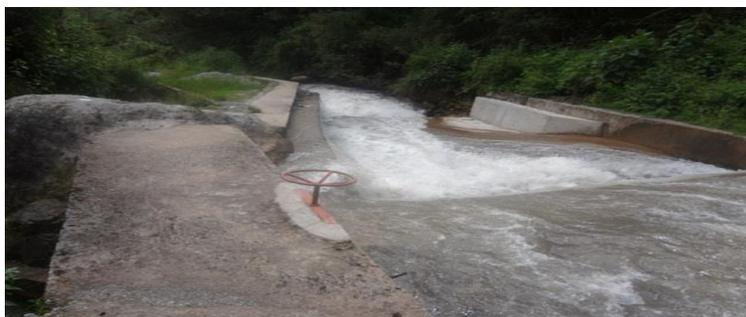
La bocatoma hacia Huyaroncca en la cota 2667 msnm y coordenadas UTM 774269 E, 8509049N, la bocatoma es rústica en base a champas y piedras, el canal en tierra tiene una longitud de 1.27 km, conduce un caudal aproximado de 8 l/s.
