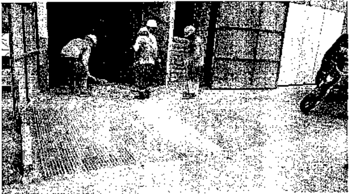
Foto N° 7 : Limpieza del Ingreso de la obra
