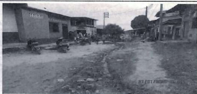
Foto 08: Discurrimiento de aguas servidas
