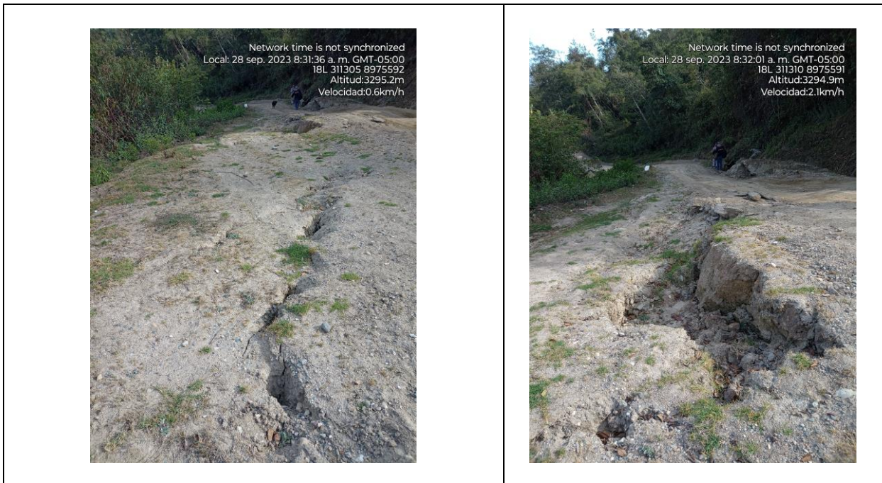
Punto crítico identificado en el tramo Urpish – Jircán, un largo de 15 metros. PI: 311303 , 8975608, alto. 3295 msnm; PF: 311296, 8975396, alt.3305 msnm
