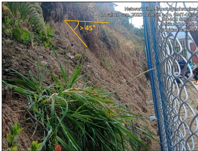
Figura 10 Vista del corte de talud en el área de estudio
