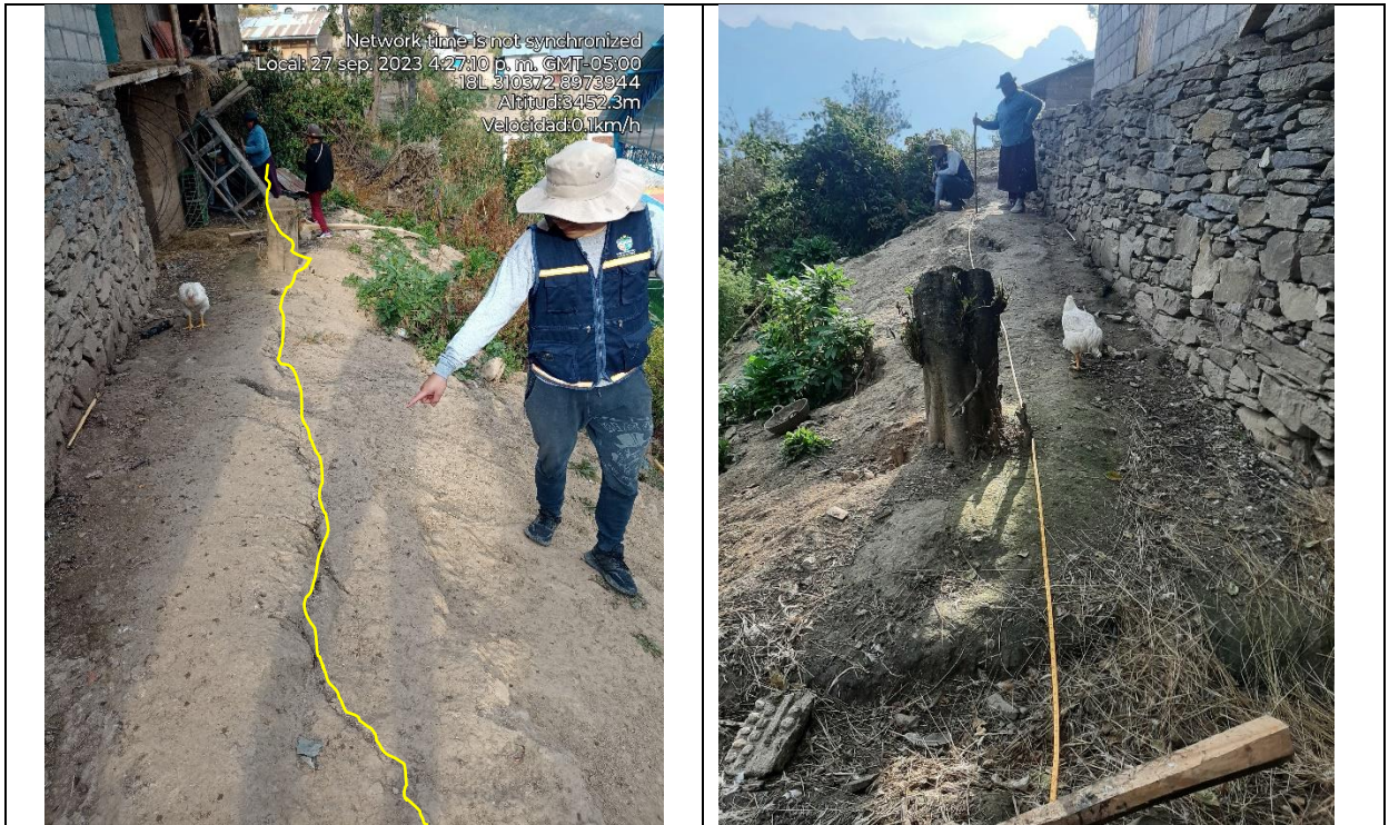
Grieta identificada en la parte posterior de la vivienda de la señora Ricardina que se encuentra a una distancia de 1.55 m de la cocina de la vivienda de la señora, asimismo tiene extensión de 14 metros y con un ancho entre 1 a 2 cm aproximadamente.
