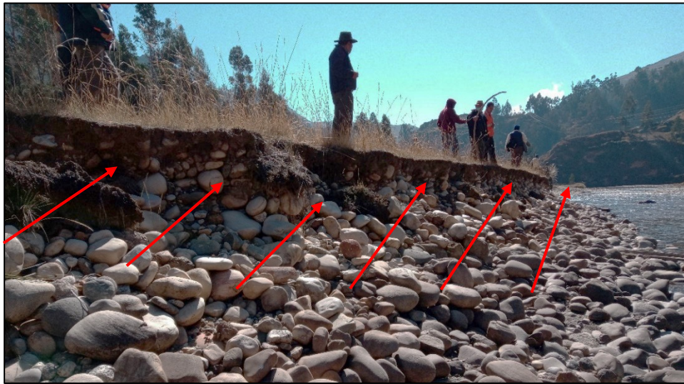
Figura 17. Área erosionada en la margen izquierda del río marañón
