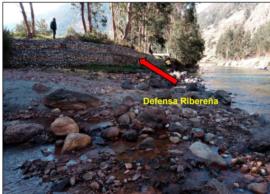
Figura 19. Defensa ribereña en la unión de la quebrada Pucayacu y el rio Marañón
