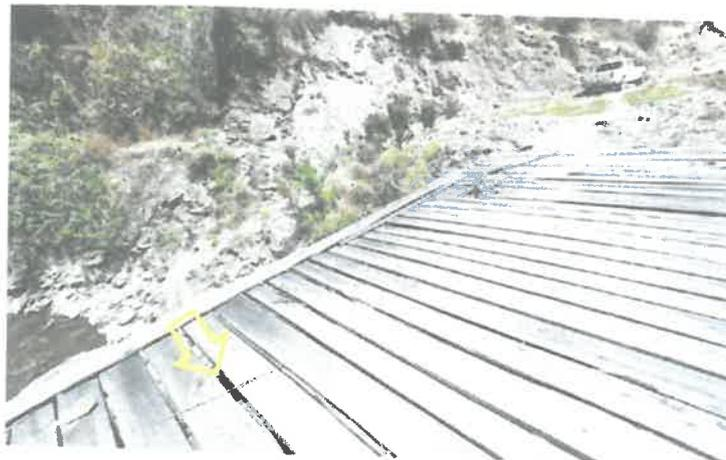
Se observa el tablero de rodadura que es soportado por madera rolliza, estas se encuentran deterioradas y afectadas por el intemperismo generándose fisuras que en conjunto debilitan al tablero.
