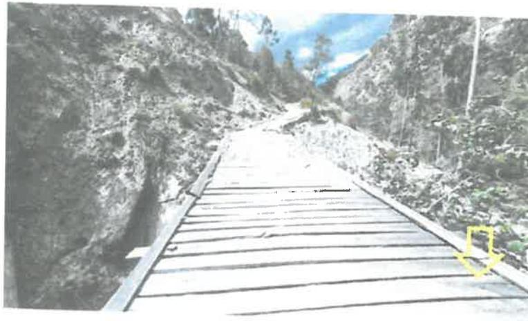
Se puede observar que el tablero de rodadura es de madera rolliza y tablas de madera, los cuales están deteriorados debido a la exposición a la intemperie y al constante tránsito de carga y mercancía por el puente
