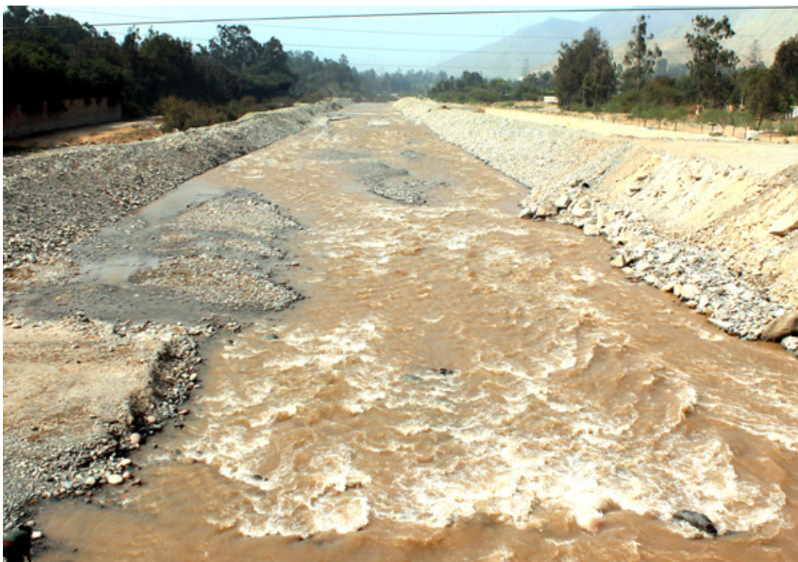
Cauce del río Lurín en el distrito de Cieneguilla. Es notoria la pérdida de la infraestructura en ambas márgenes.
