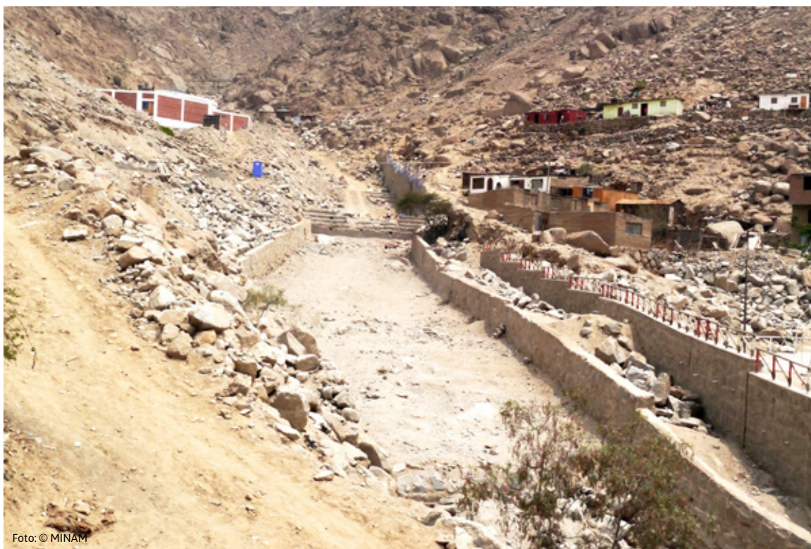
Cauce de quebrada Santo Domingo – Chosica. Nótese la implementación de medidas de encausamiento de huaicos y construcción de diques.
