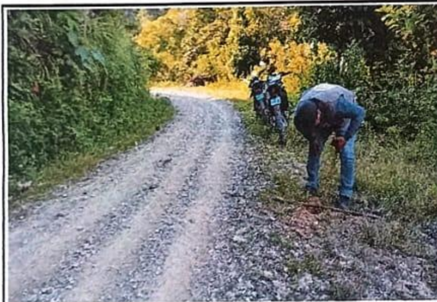
Foto 03. Se observa un espesor de pavimento de 0.17 cm. Progresiva 00+500, no tiene bombeo.
