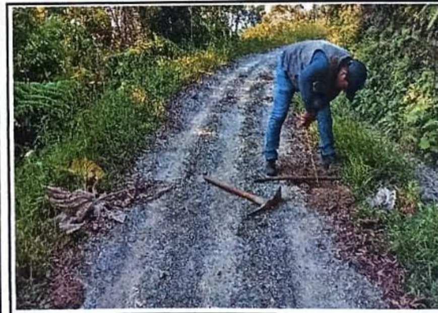
Foto 12. Se observa un espesor de pavimento de 0.13 cm. Progresiva 02+750, no tiene bombeo.
