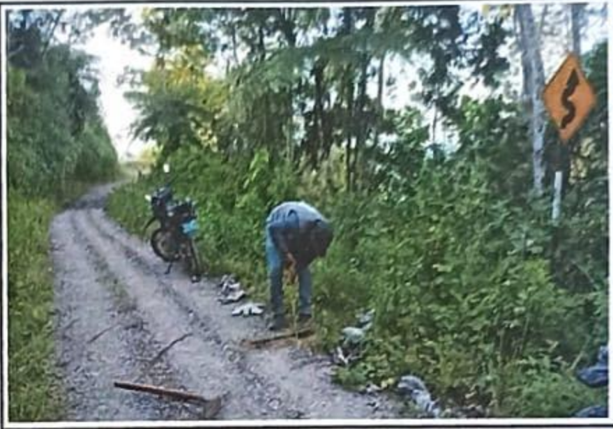
Foto 14. Se observa un espesor de pavimento de 0.14 cm. Progresiva 03+250, no tiene bombeo.
