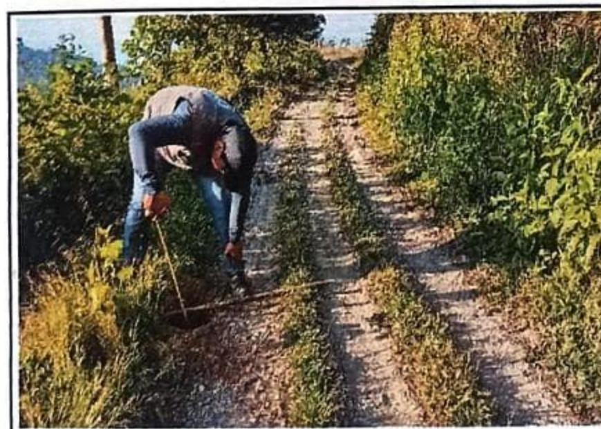
Foto 11. Se observa un espesor de pavimento de 0.15 cm. Progresiva 02+500, no tiene bombeo.
