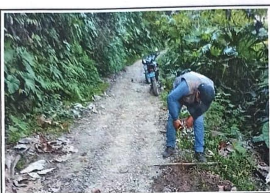
Foto 07. Se observa un espesor de pavimento de 0.16 cm. Progresiva 01+500, no tiene bombeo.
