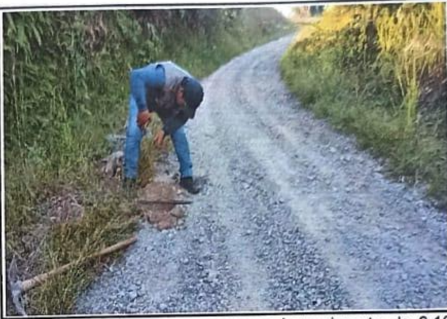
Foto 08. Se observa un espesor de pavimento de 0.16 cm. Progresiva 01+750, no tiene bombeo.
