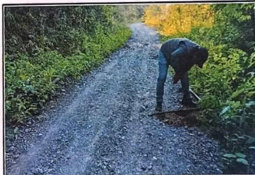
Foto 04. Se observa un espesor de pavimento de 0.17 cm. Progresiva 00+750, no tiene bombeo
