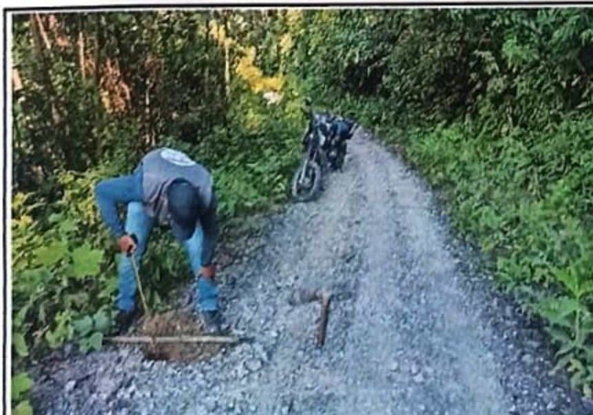
Foto 05. Se observa un espesor de pavimento de 0.16 cm. Progresiva 01+000, no tiene bombeo
