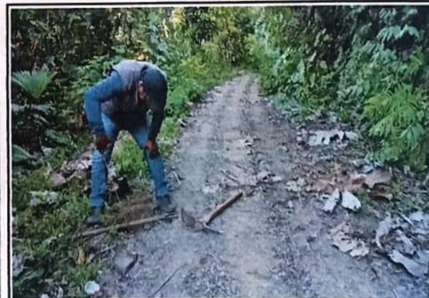
Foto 06. Se observa un espesor de pavimento de 0.15 cm. Progresiva 01+250, no tiene bombeo
