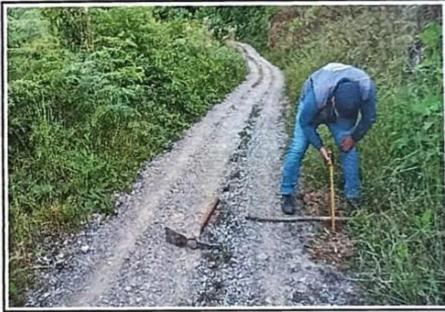
Foto 16. Se observa un espesor de pavimento de 0.14 cm. Progresiva 03+750, no tiene bombeo.
