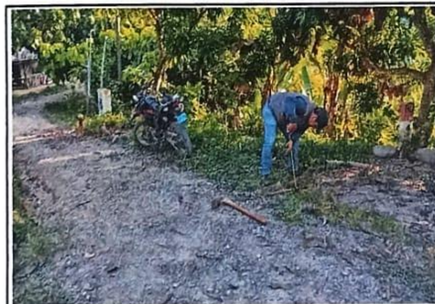
Foto 17. Se observa un espesor de pavimento de 0.16 cm. Progresiva 04+000, no tiene bombeo.
