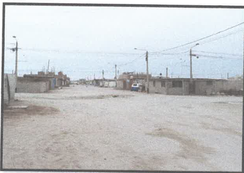
Fotografía N°03: Falta de infraestructura peatonal, bermas y pavimentación
