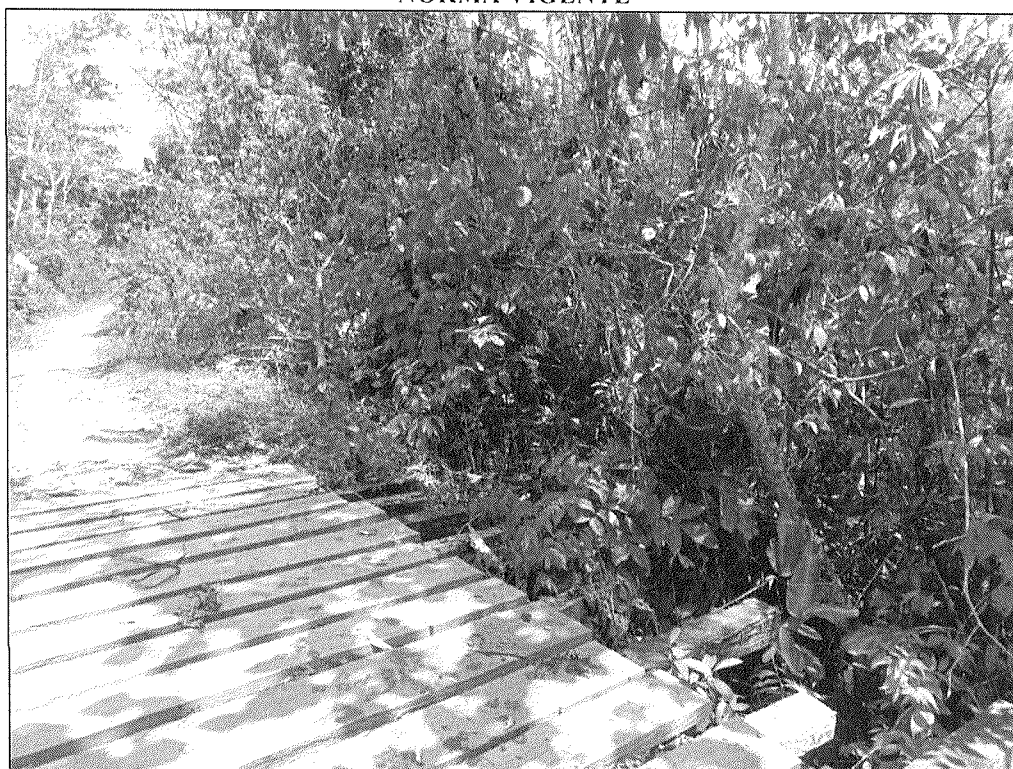
FOTO N° 2: VISTA DEL PUENTE; CON ESTRUCTURA DE MADERA INADECUADA RESPECTO A NORMA VIGENTE
