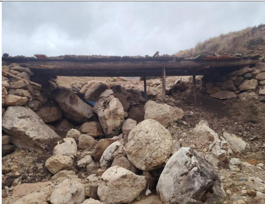
**Fotografía 2.** En esta fotografía, se aprecia el muro de concreto ciclópeo, que se encuentran en estado colapsado, además de la presencia de rocas de gran tamaño en el cauce la quebrada.
