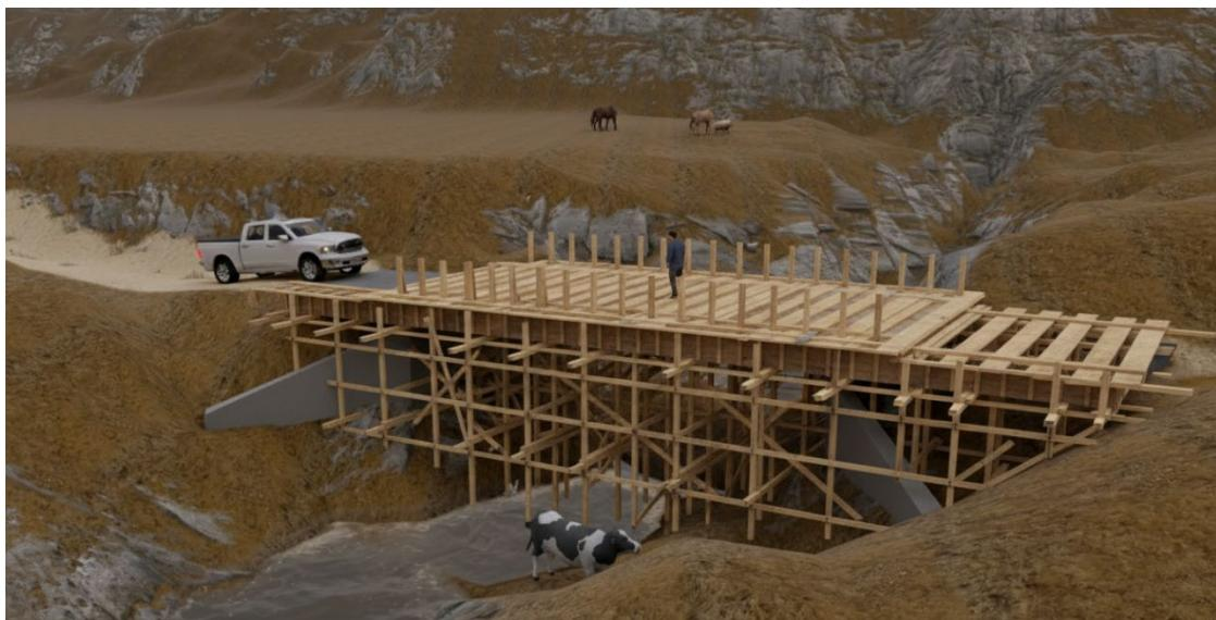
Ilustración 16. Detalle encofrado de la losa.
