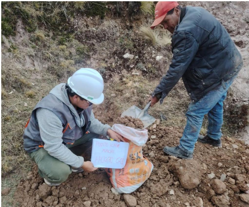
Ilustración 6. Vista de extracción identificación de calicata
