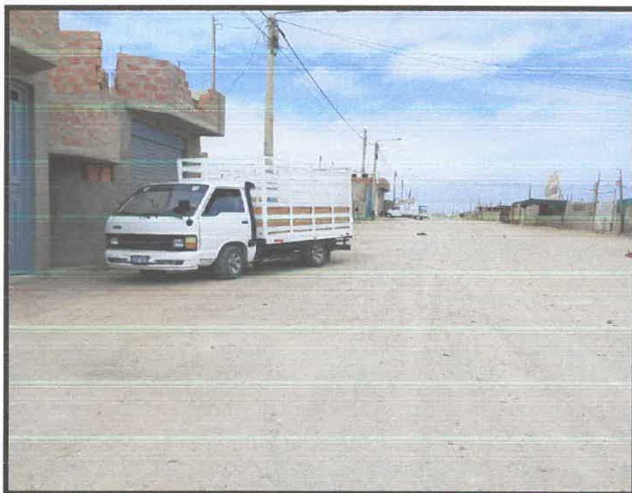
Fotografía N°03: En la AVENIDA 06 se ha identificado la falta de infraestructura peatonal en las intersecciones
