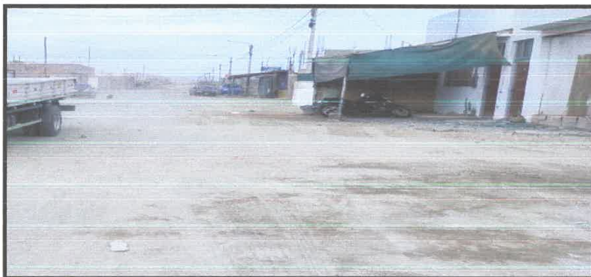
Fotografía N°02: En la AVENIDA 06 se ha identificado la falta de infraestructura peatonal en las intersecciones
