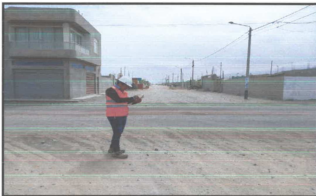
Fotografía N°04: En la AVENIDA 06 se ha identificado la falta de infraestructura vehicular adecuada
