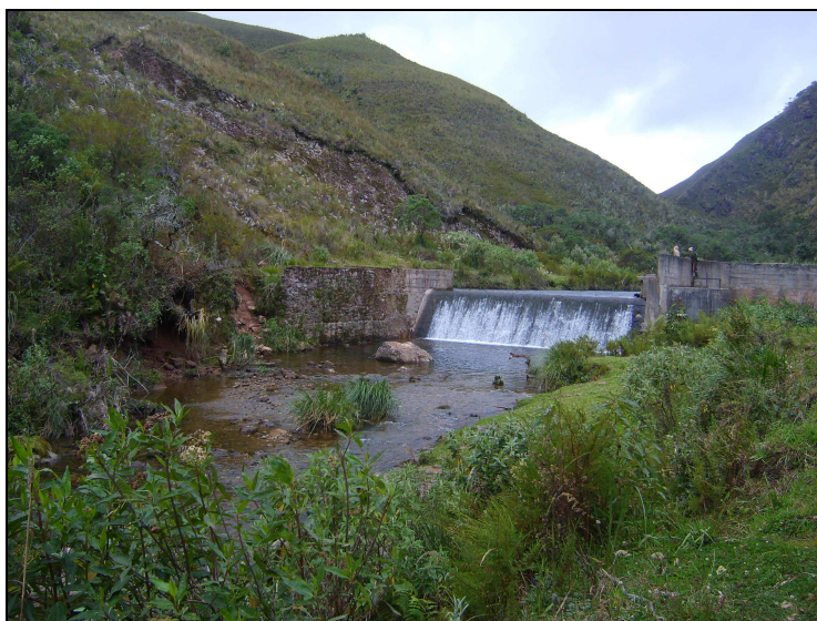
FOTO 26 Captación de agua quebrada Tilacancha
