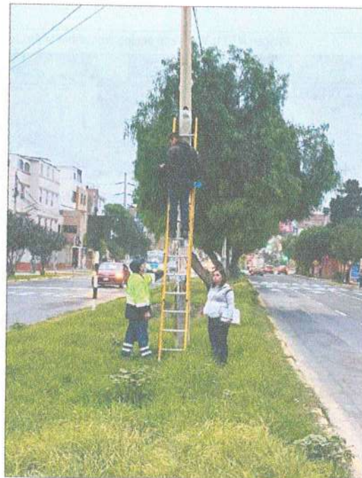
Imagen N° 9: Instalación de las cámaras de video en la Av. América Oeste.
