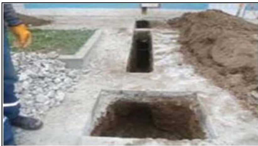
Fotografía 3.- Construcción de fosa para acometida y tubería secundaria (imagen referencial)
