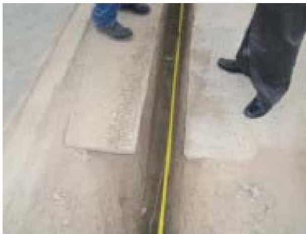
Fotografía 5.- Tubería de polietileno instalada (imagen referencial)
