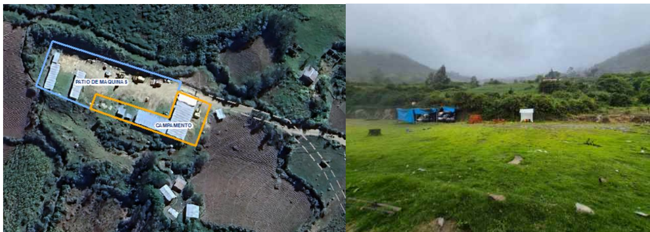
Figura 17. Vista satelital del patio de máquinas y de campo.
