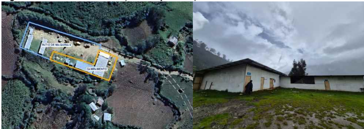
Figura 16. Vista satelital del campamento y de campo.
