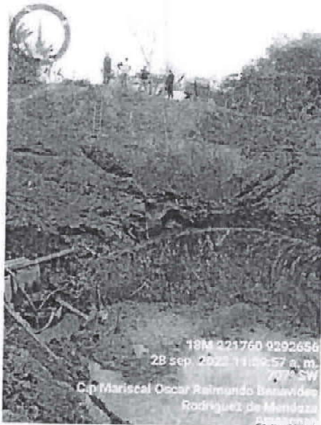
Fotografía 13: Excavación para las zapatas del puente Tingo San Antonio
